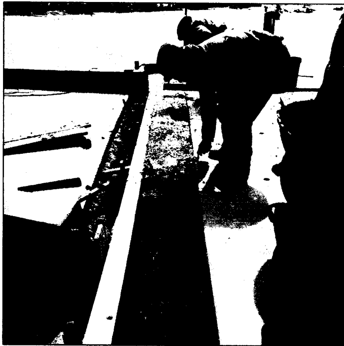
FOTO N° 4. Vaciado de Concreto Fibro reforzado en Juntas de dilatación de Acero Galvanizado en caliente.
