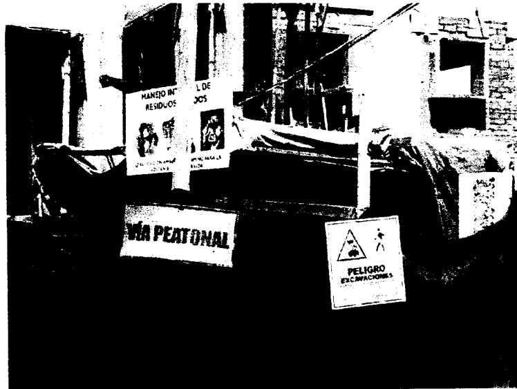
Foto 5: señalización en el exterior de la obra
